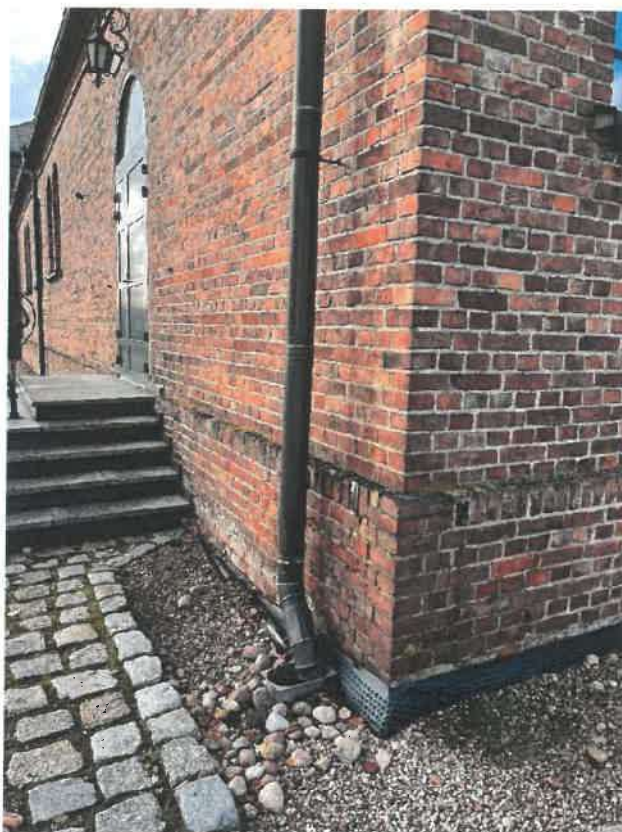
Zdj. nr 9 – Utwardzenie ciągu komunikacyjnego i warstwy odsączającej przy kościele
