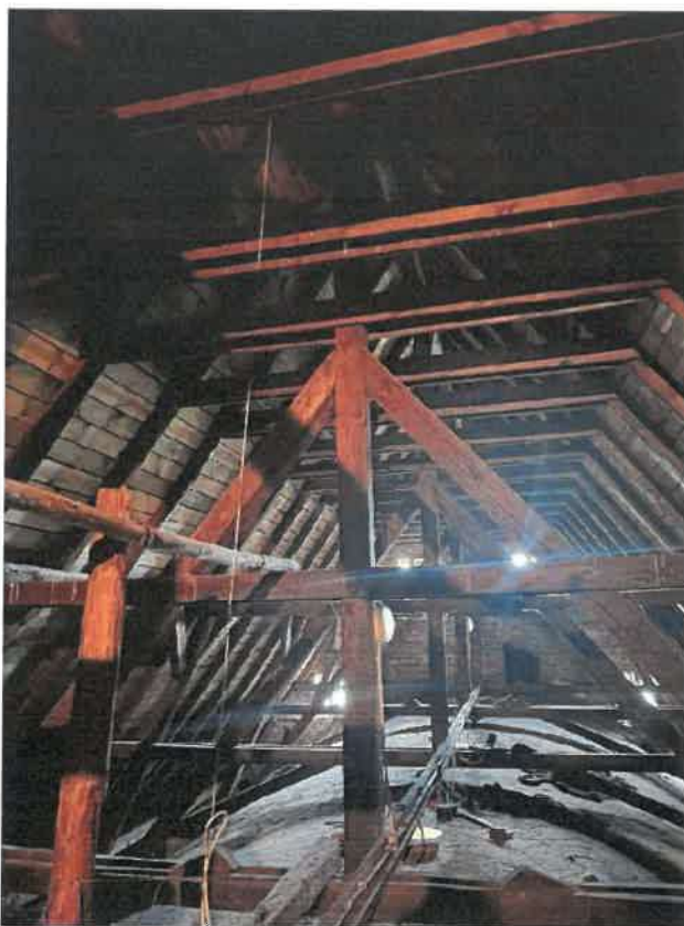
Zdj. nr 21 – Więźba dachowa nad nawą główną
