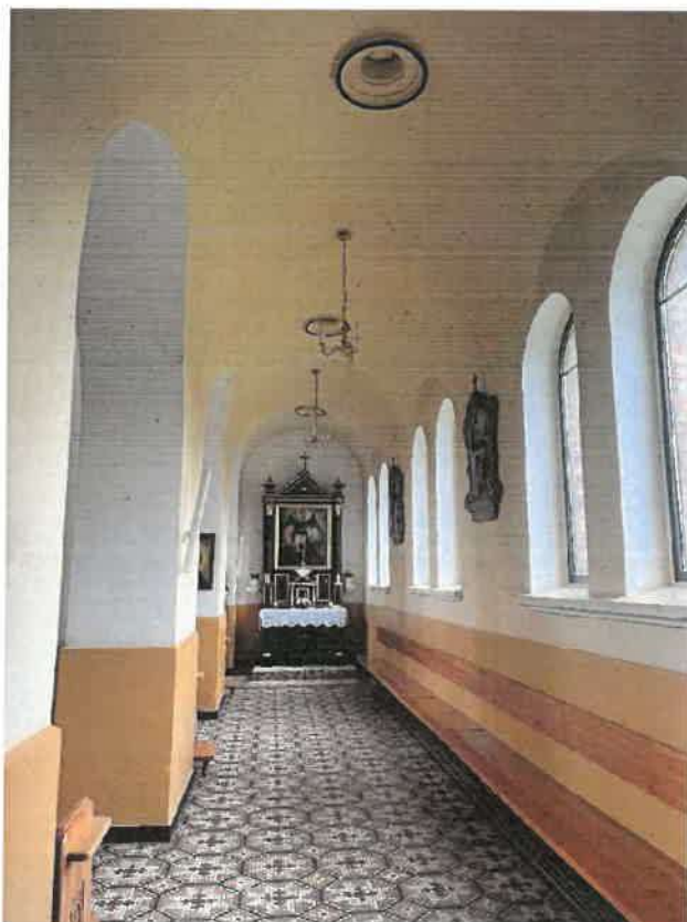
Zdj. nr 17 – Rytmicznie występujące pęknięcia na sklepieniu nawy bocznej
