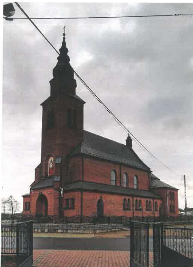
Zdj. nr 5 - Widok kościoła od strony północnej
