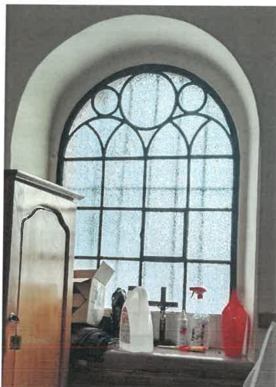
Zdj. nr 42 - Okno O8 od wewnątrz
