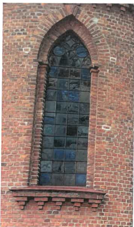
Zdj. nr 21 - Okno O1 z witrażem od zewnątrz
