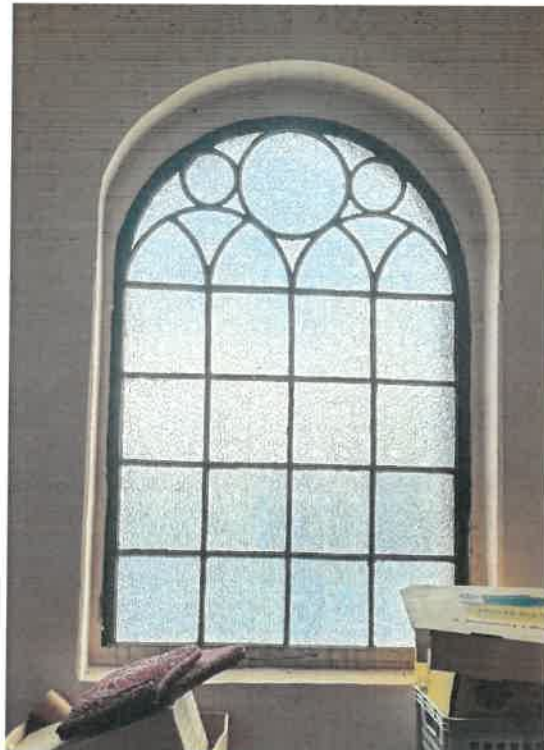
Zdj. nr 50 - Okno O9 od wewnątrz
