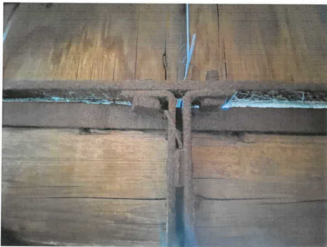
Zdj. nr 29 – Połączenie elementów konstrukcji żaluzji
