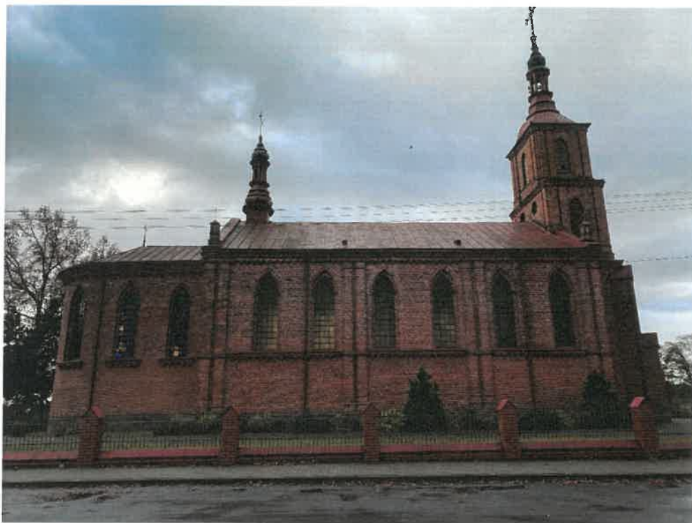
Zdj. nr 2 - Widok kościoła od strony północnej
