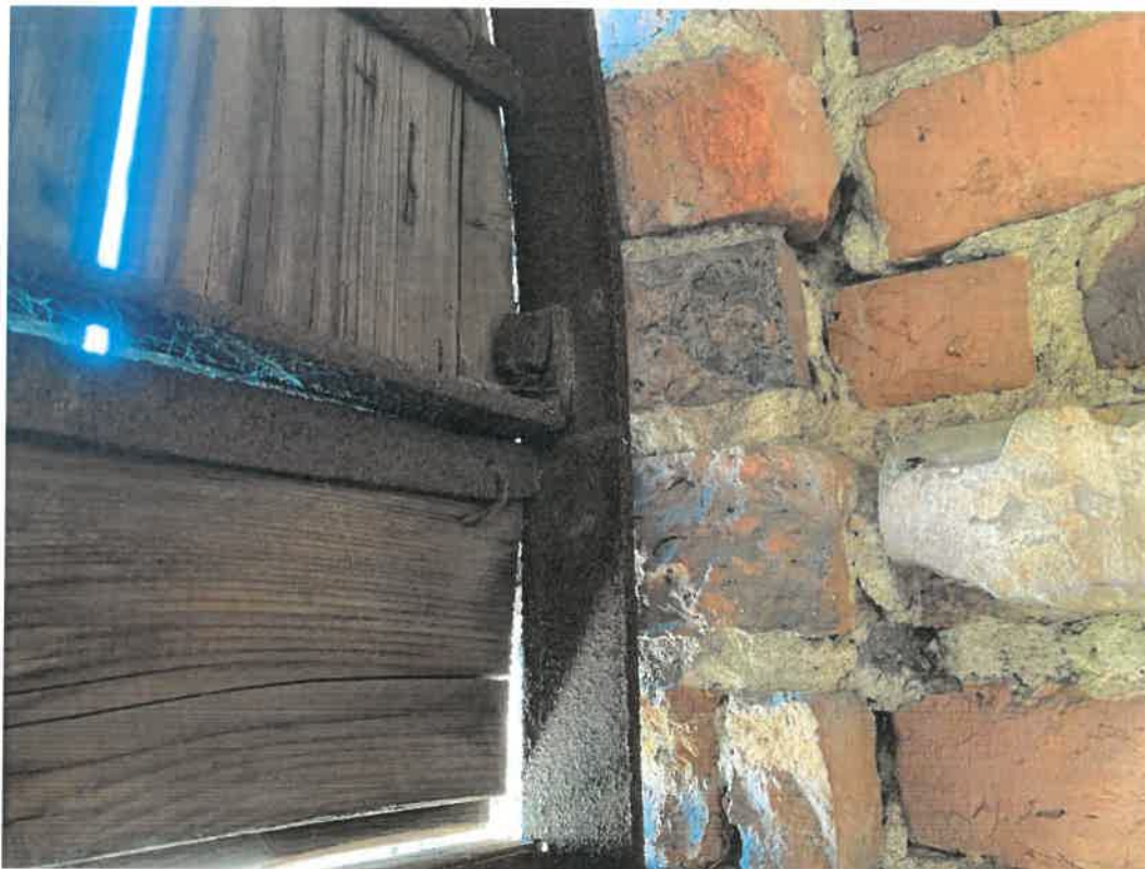
Zdj. nr 30 – Połączenie elementów konstrukcji żaluzji
