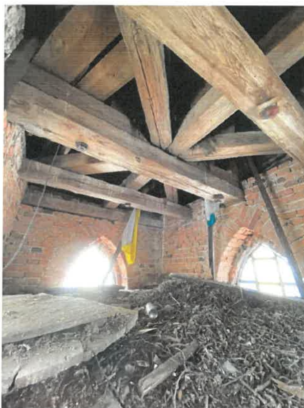
Zdj. nr 39 – Konstrukcja hełmu wieży
