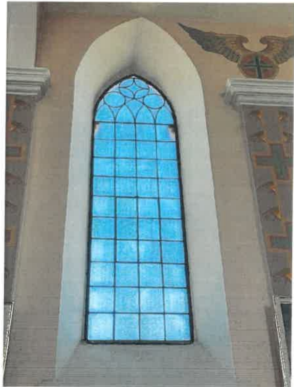
Zdj. nr 19 - Okno O1 od wewnątrz
