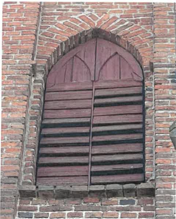
Zdj. nr 25 - Żaluzja O4 od zewnątrz
