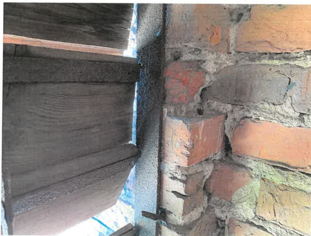
Zdj. nr 33 – Połączenie żaluzji z konstrukcją
