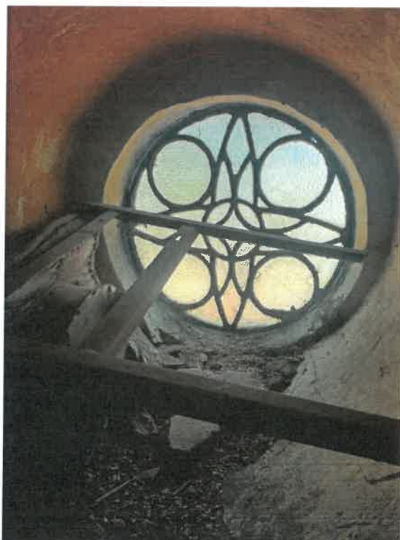
Zdj. nr 38 - Okno O7 od zewnątrz
