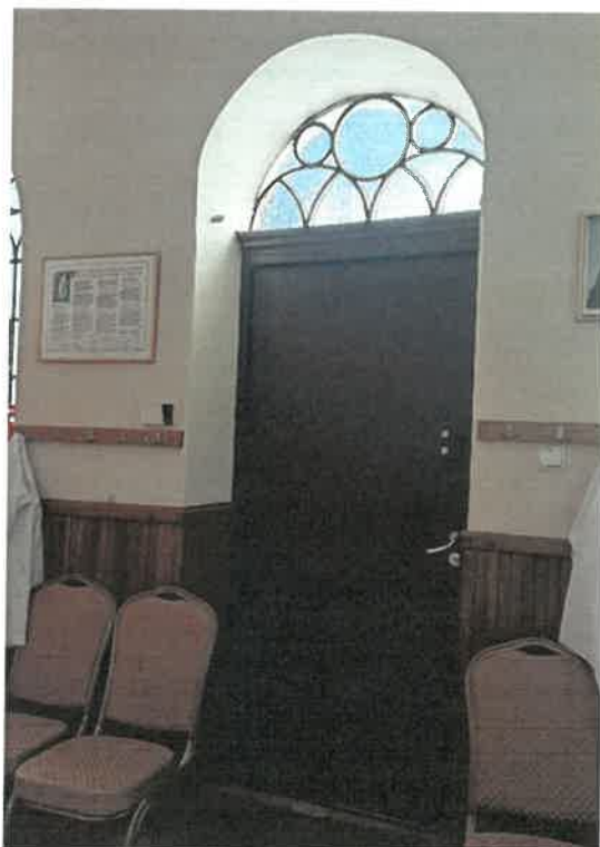
Zdj. nr 51 - Okno O12 od wewnątrz
