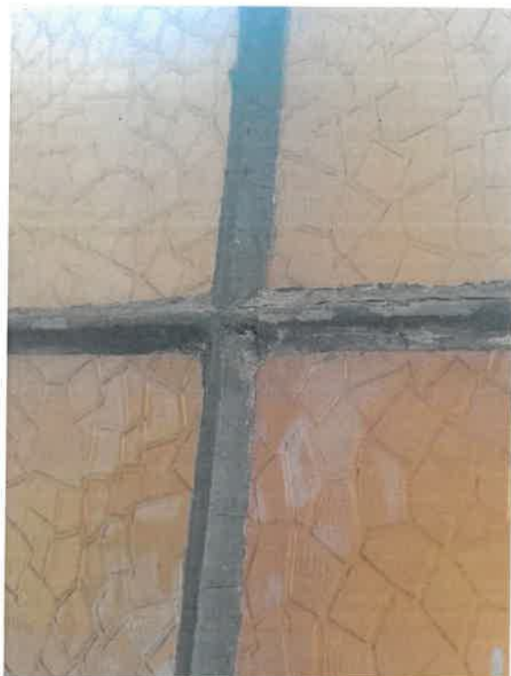
Zdj. nr 43 – Kitowanie okna O8
