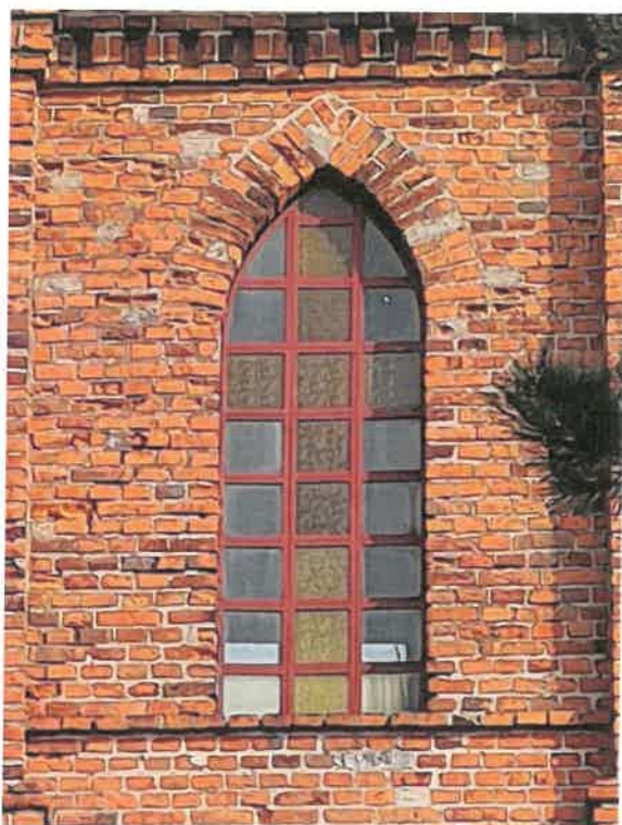
Zdj. nr 23 - Okno O2 od zewnątrz
