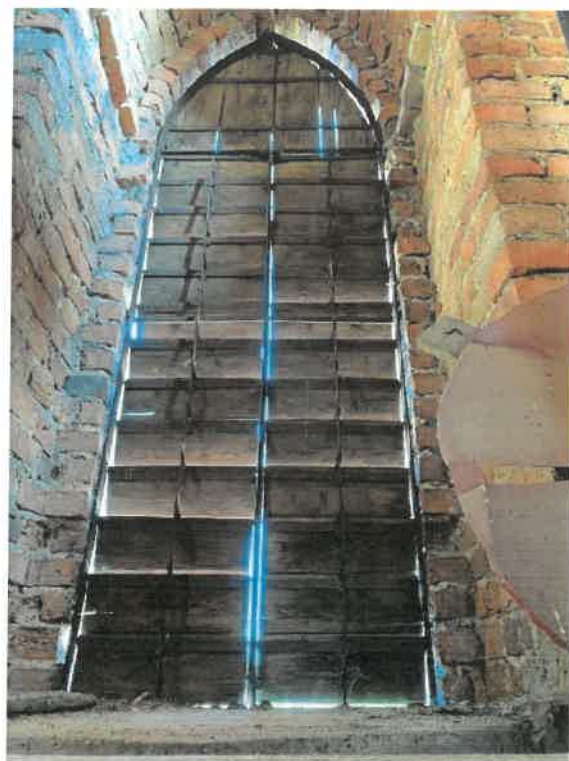
Zdj. nr 26 - Żaluzja O4 od wewnątrz
