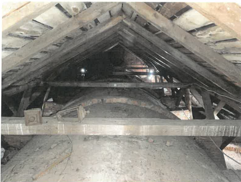
Zdj. nr 38 – Więźba dachowa nad nawą główną
