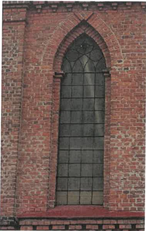
Zdj. nr 18 - Okno O1 od zewnątrz
