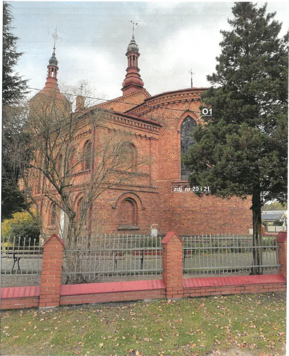
Zdj. nr 16 - Widok elewacji południowo-wschodniej kościoła z oznaczeniem stolarki okiennej kwalifikującej się do wymiany
