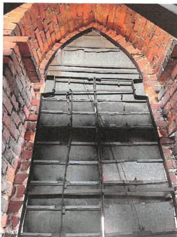
Zdj. nr 36 - Żaluzja O5 od wewnątrz
