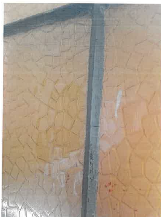
Zdj. nr 44 – Kitowanie okna O8
